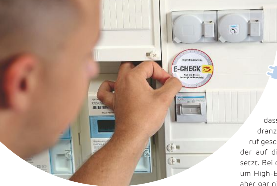
Elektrotechniker klebt E-CHECK Plakette in Verteiler.
