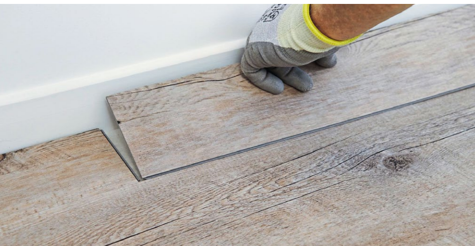
Im Gegensatz zu starren Rigid-Belägen ist Solid Clic elastisch und lässt sich leicht mit einem Verlegemesser zuschneiden – auch bei herausfordernden Arbeiten wie zum Beispiel dem Wandanschluss.
